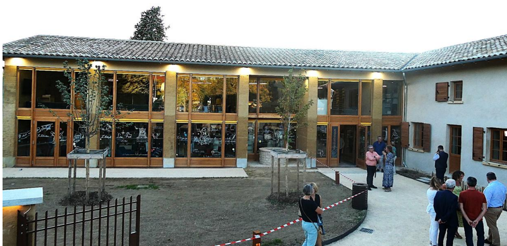
Un bâtiment aux volumes épurés qui laisse entrer la lumière naturellement.
