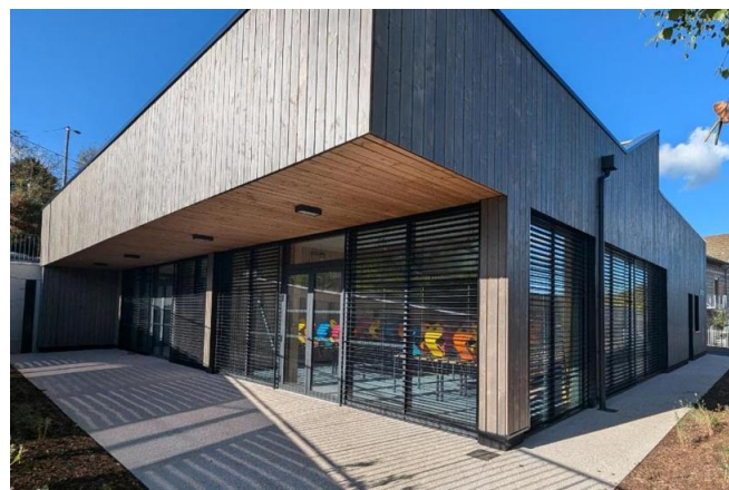
Le complexe scolaire de Saint-Nizier-d'Azergues est équipé de panneaux photovoltaïques pour favoriser l'autoconsommation. Photo fournie/Ville de Saint-Nizier-d'Azergues
